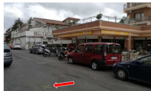
Fuite sur conduite principale dans la Via die Bentivoglio au niveau du n°30
