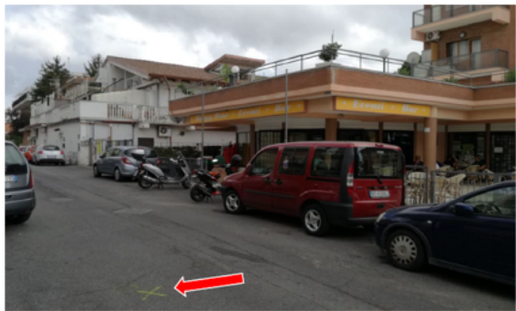
Pérdidas en la tubería principal en Via dei Bentivoglio a la altura del N° 30
