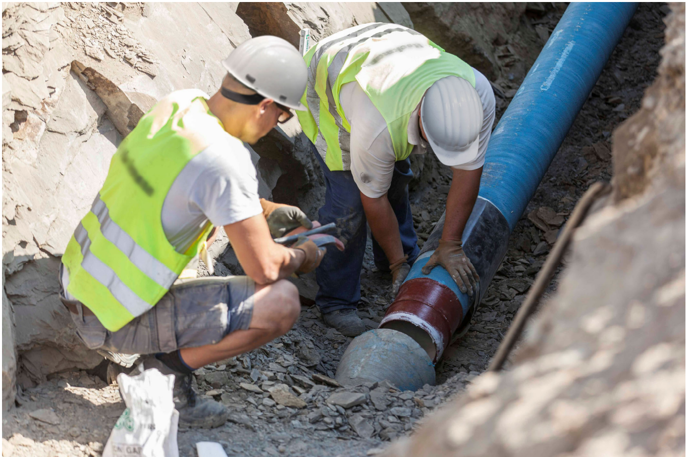
Pose de tuyaux/montage dans la tranchée ouverte
