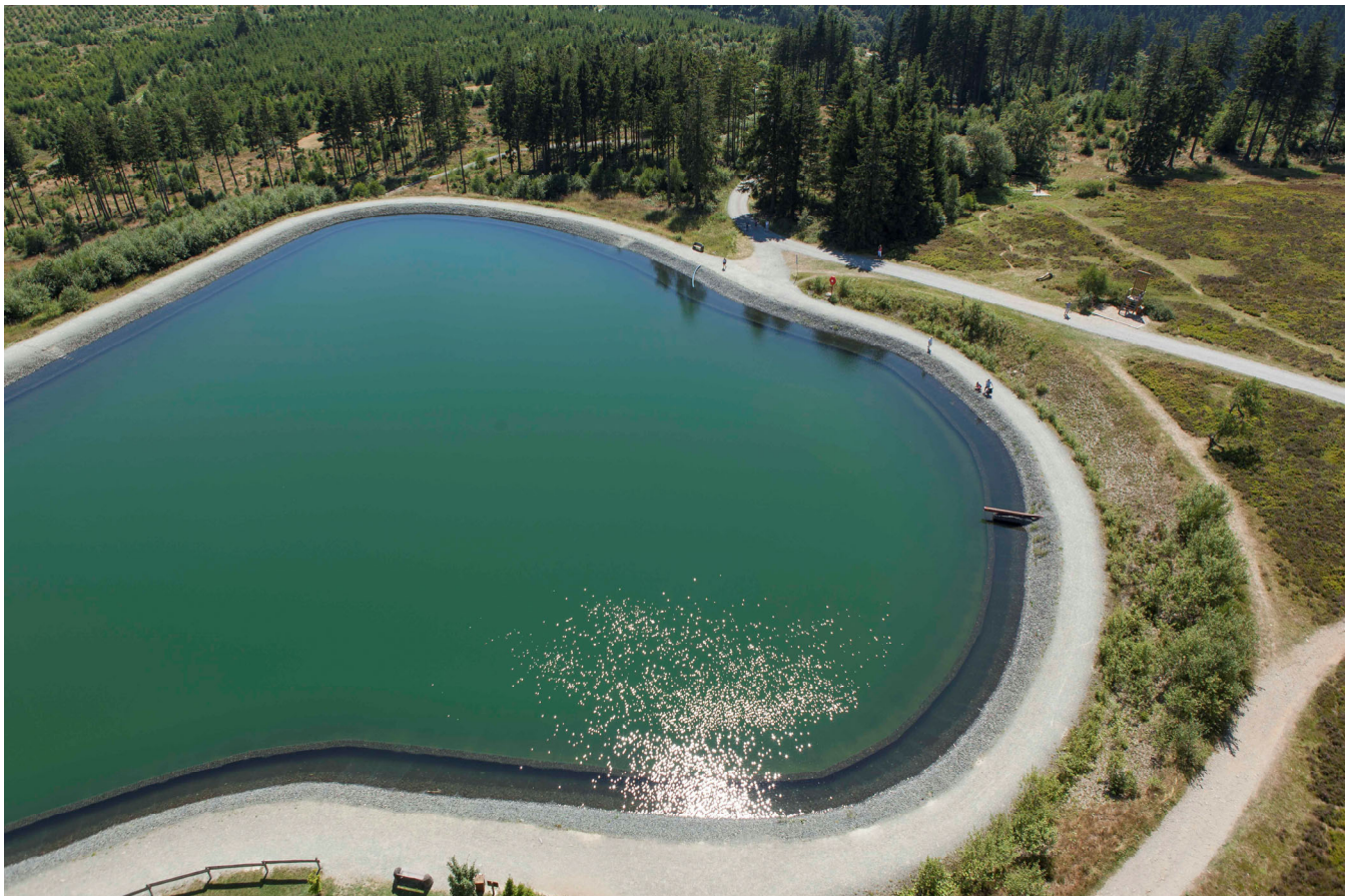
Vue sur le réservoir, déjà construit en 2007
