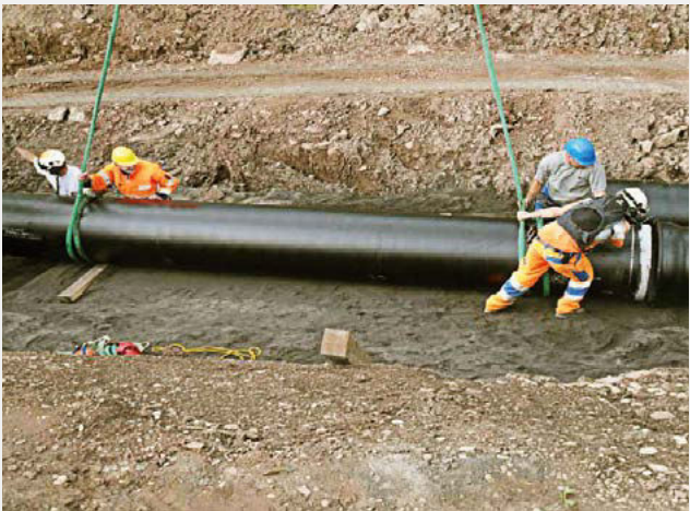
Fig. 9 Certains des tuyaux en fonte ductile vonRoll ont dû être installés par hélicoptère. Die duktilen Gussrohre vonRoll DUCPUR mussten zum Teil per Helikopter installiert werden.
