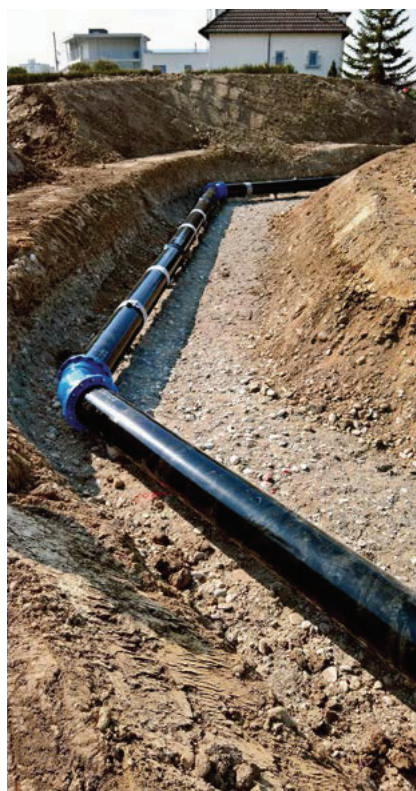
Fig. 2 Modification de la conduite de transport DN 400 du fait du rond-point en béton
