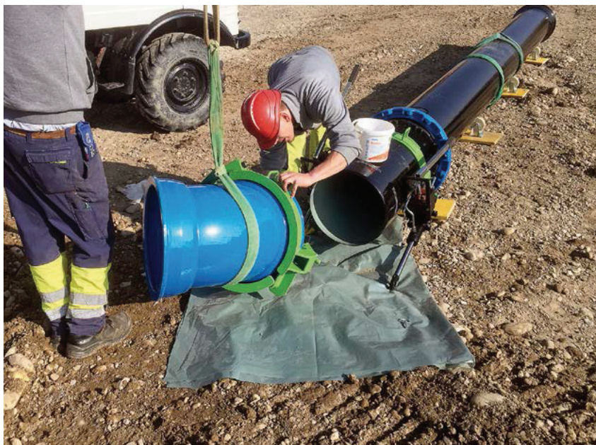
Fig. 3 Prémontage coude ECOFIT DN 400 à l'extérieur de la fosse avec appareil de pose hydraulique
