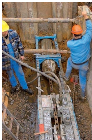
Pose de tuyaux sans tranchée vonRoll ECOPUR.
