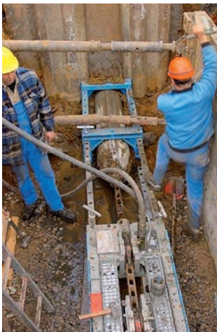
Grabenloser Rohrleitungsbau mit Rohren vonRoll ECOPUR.
