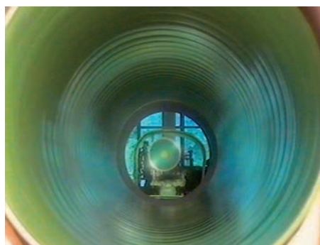
Automatische Innenbeschichtung mit Polyurethan (PUR).
