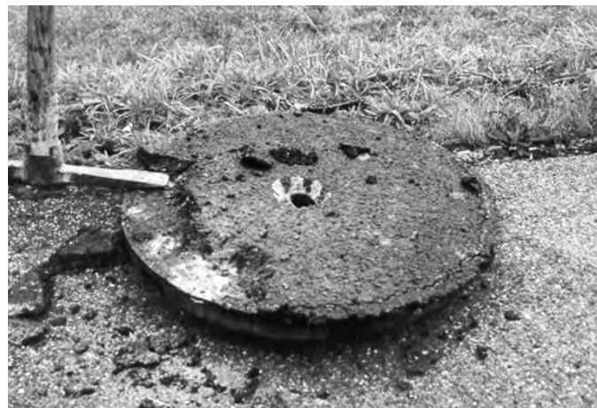
Rimozione e pulizia della copertura
