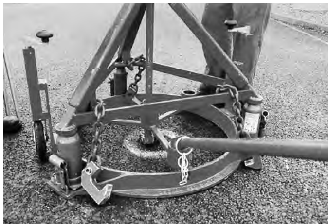
Sollevamento della copertura, intaglio della pavimentazione
