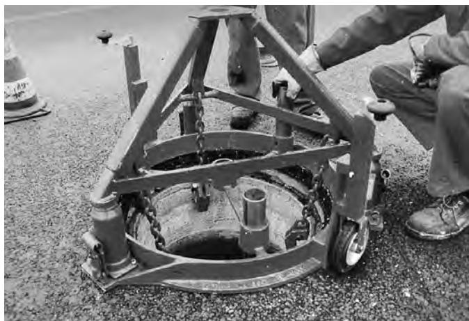
Sollevamento del telaio servendosi della pressa idraulica
