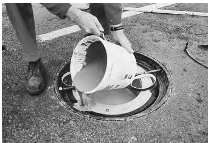
Applicazione del cassero Fig. 3280, Riempimento con calcestruzzo per pozzi Addiment 913142
