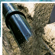
Schnell und günstig verlegen
