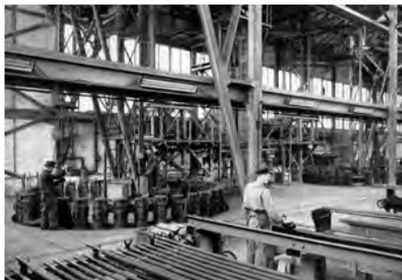
Карусельная линия с вертикальными песчаными формами около 1900 г
