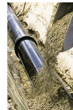
Facilité de pose
